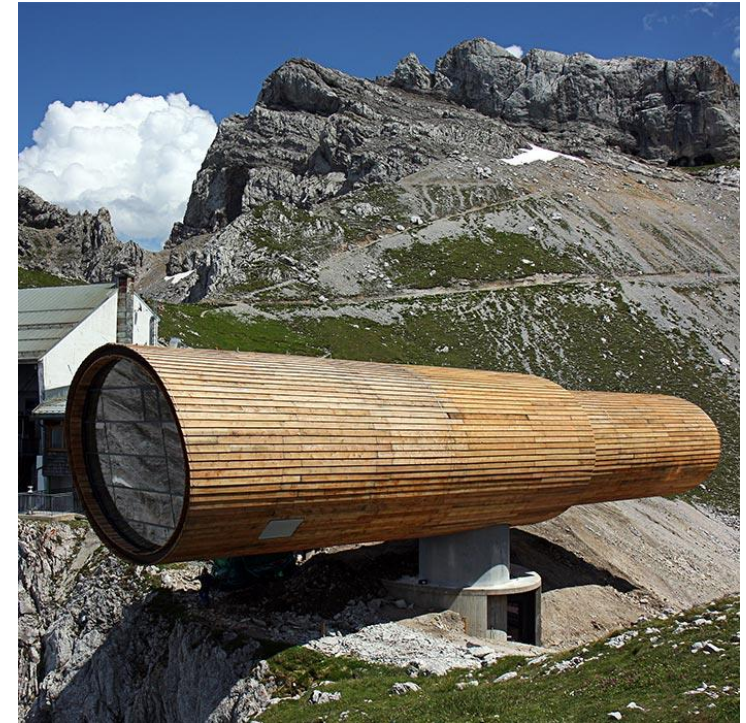
1.200 t Beton, Kosten 2,7 Mio €
